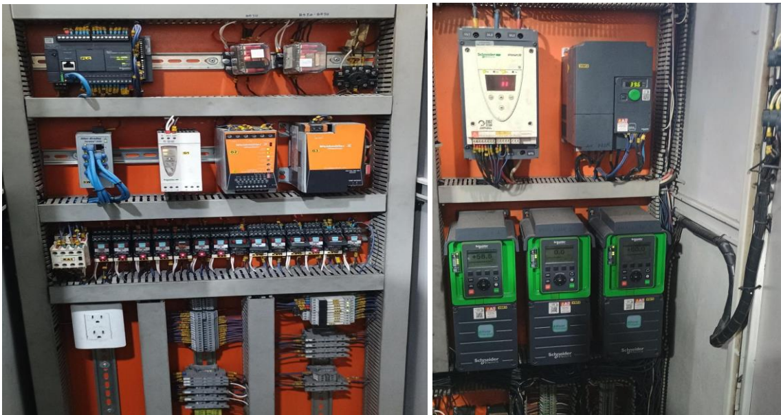
Figura 7. Tablero eléctrico de control.
