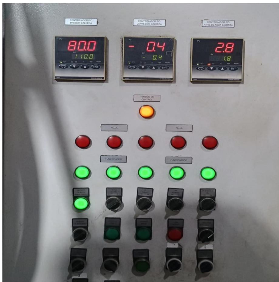
Figura 8. Panel de control de la caldera.
