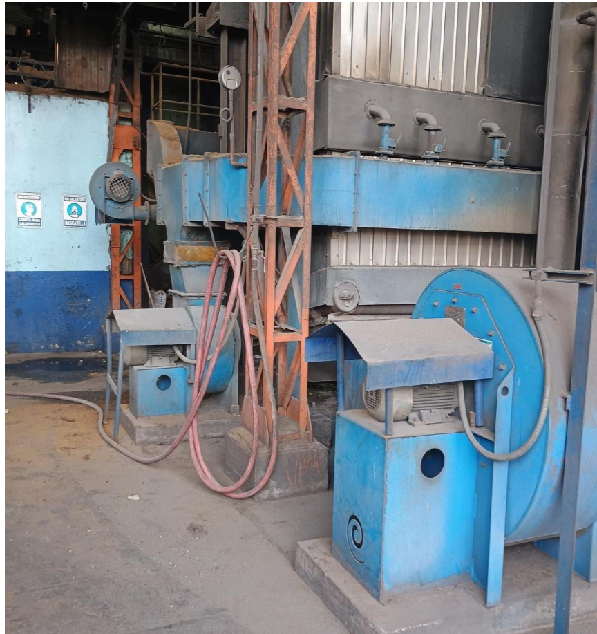
Figura 2. Ventiladores primarios y secundarios de la caldera.
