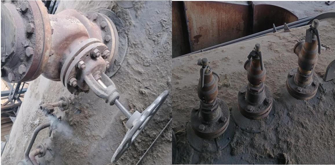
Figura 6. Válvula de control de la caldera - Válvulas de alivio de la caldera.
