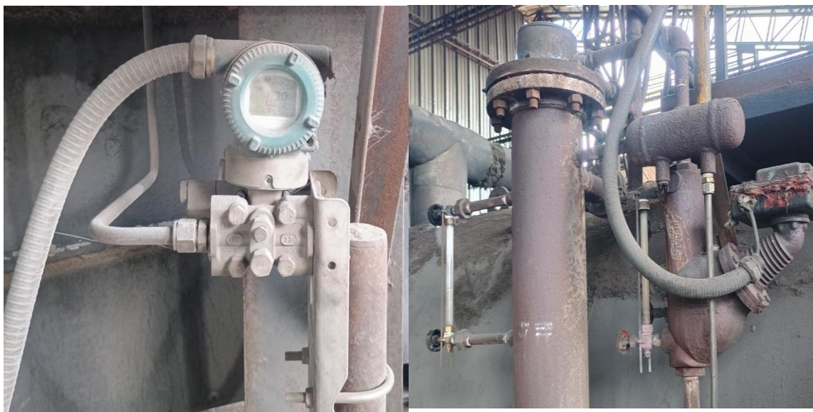
Figura 5. Sensor/transmisor de presión diferencial - Medidor e indicador de nivel.
