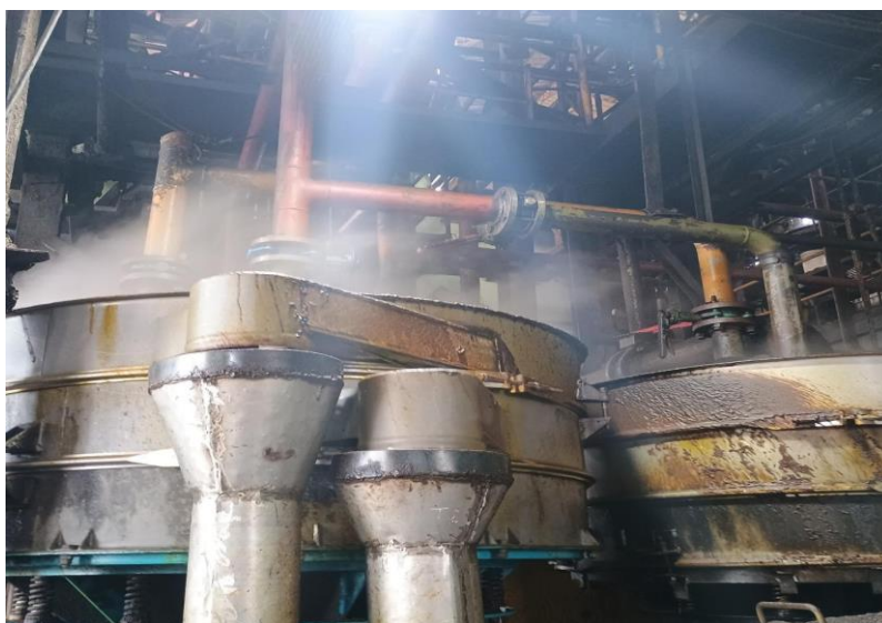
Figura 4. Salida de vapor en una sección de la caldera.
